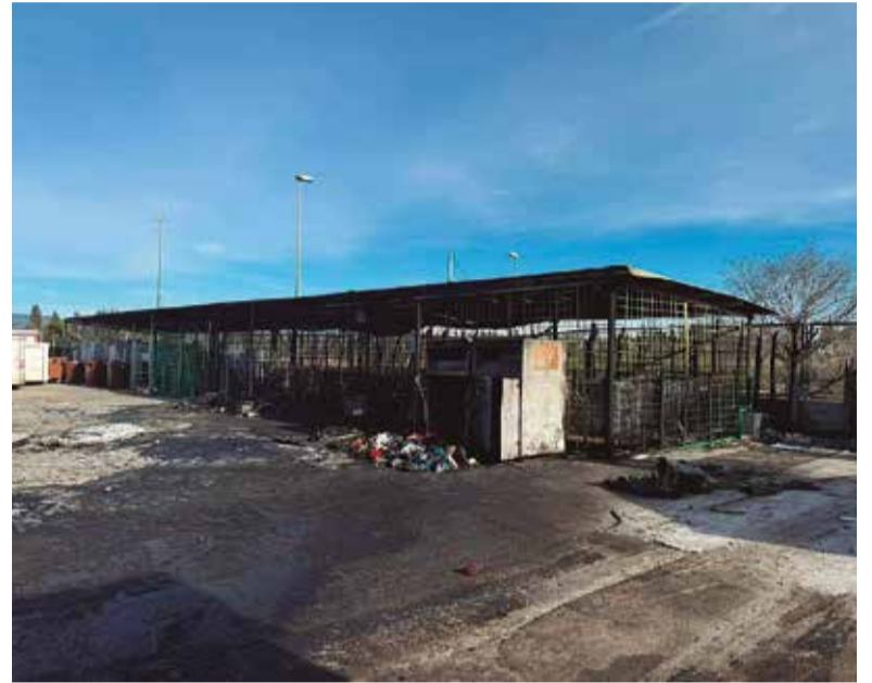
Estat en què va quedar la deixalleria de Bellvei. ✱ CONSELL COMARCAL
