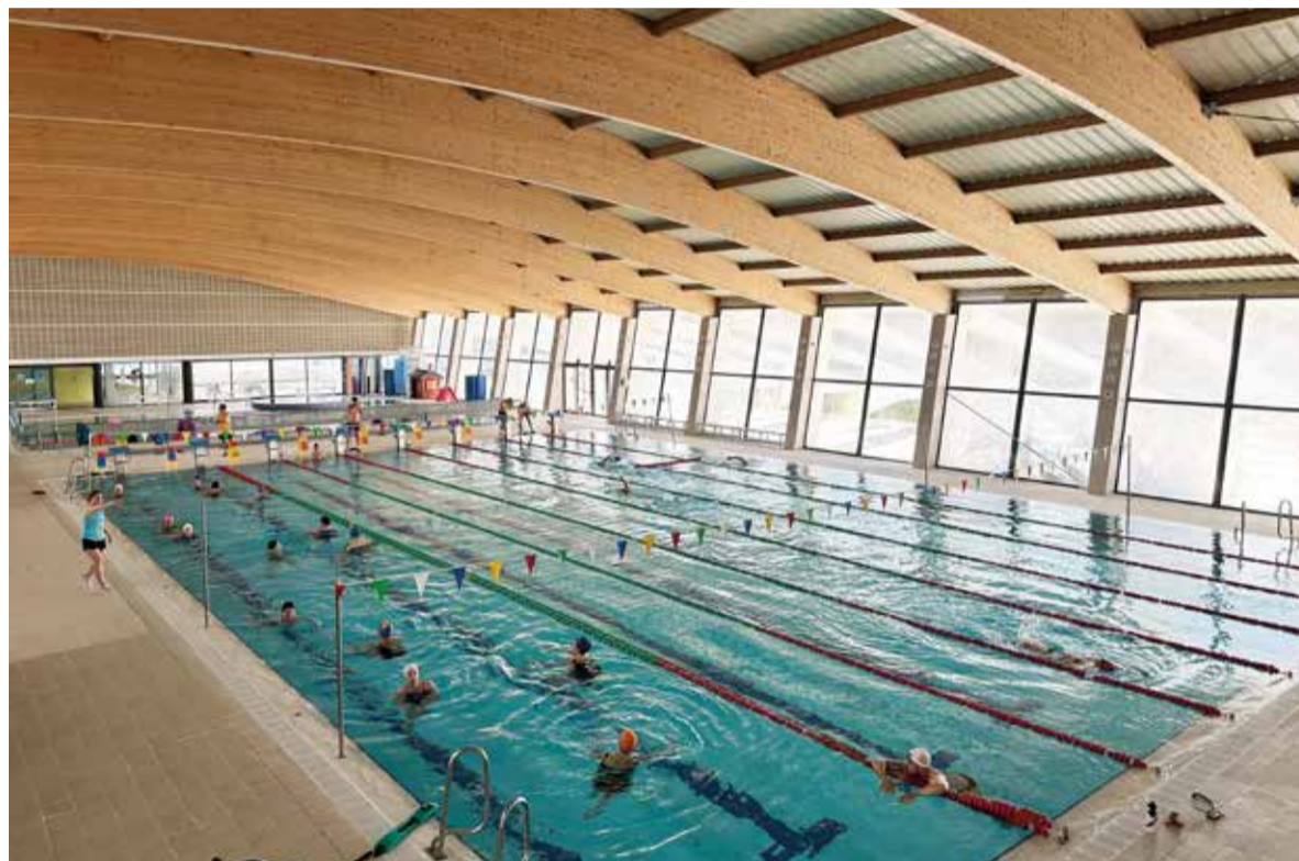
L'equipament ha anat reobrint progressivament, després dels estralls provocats per la dana del juliol. ✖ AJUNTAMENT
