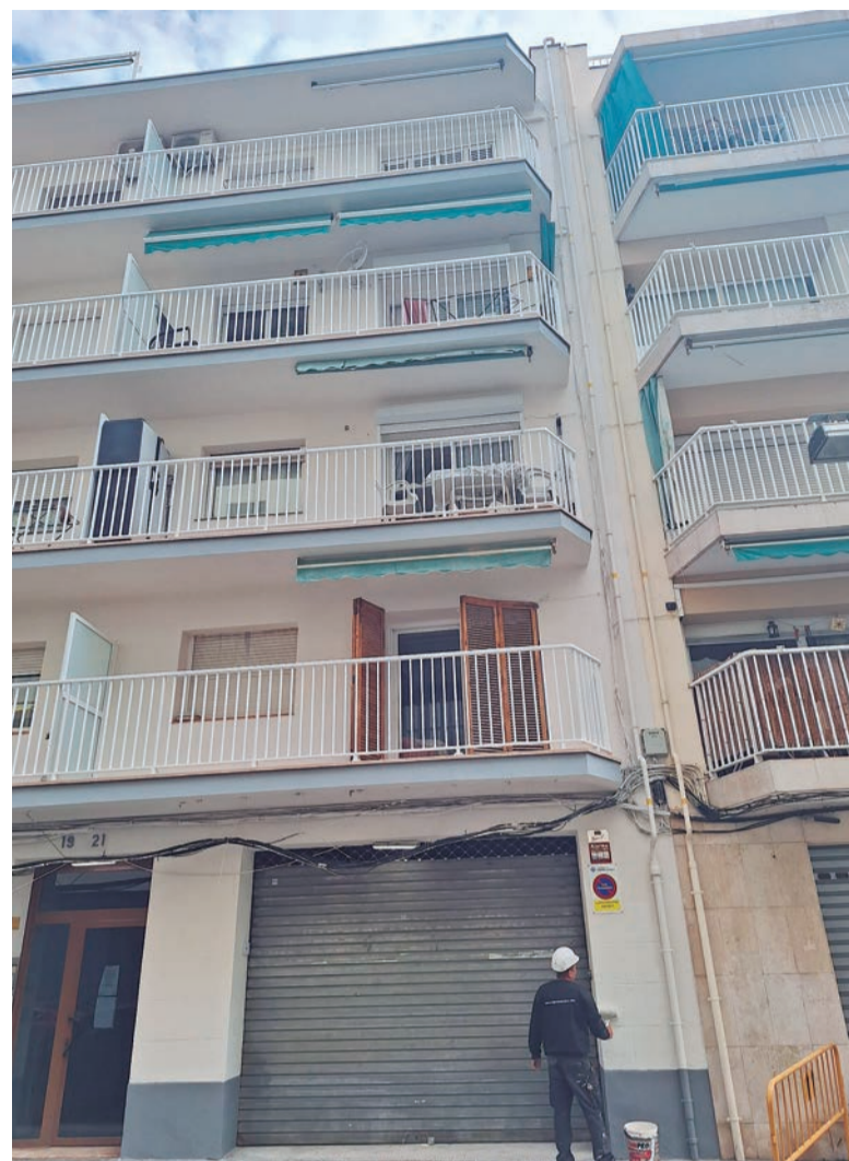
CLG Construpro és una empresa especialitzats en rehabilitació de façanes.
