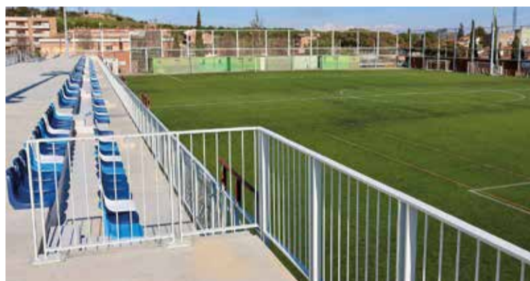
Les obres a la Triola podran començar aquest any. ✦ AJUNTAMENT
