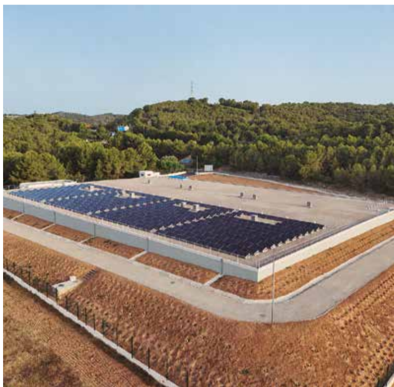
El dipòsit té 364 plaques solars a la coberta. ✱ CAT
