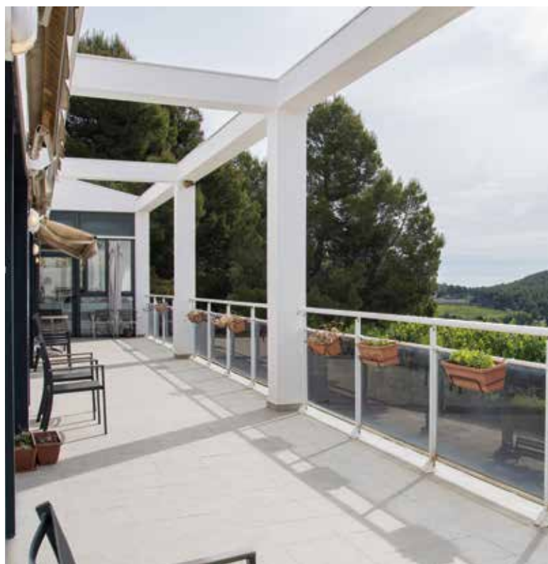
Les instal·lacions han estat dissenyades per facilitar el confort dels residents.
