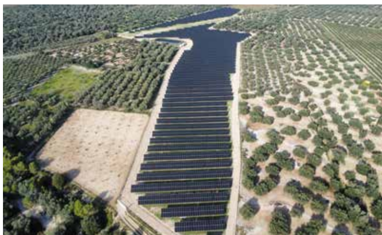
Imatge d'arxiu d'un camp fotovoltaic a Ulldecona. ✱ ACN
