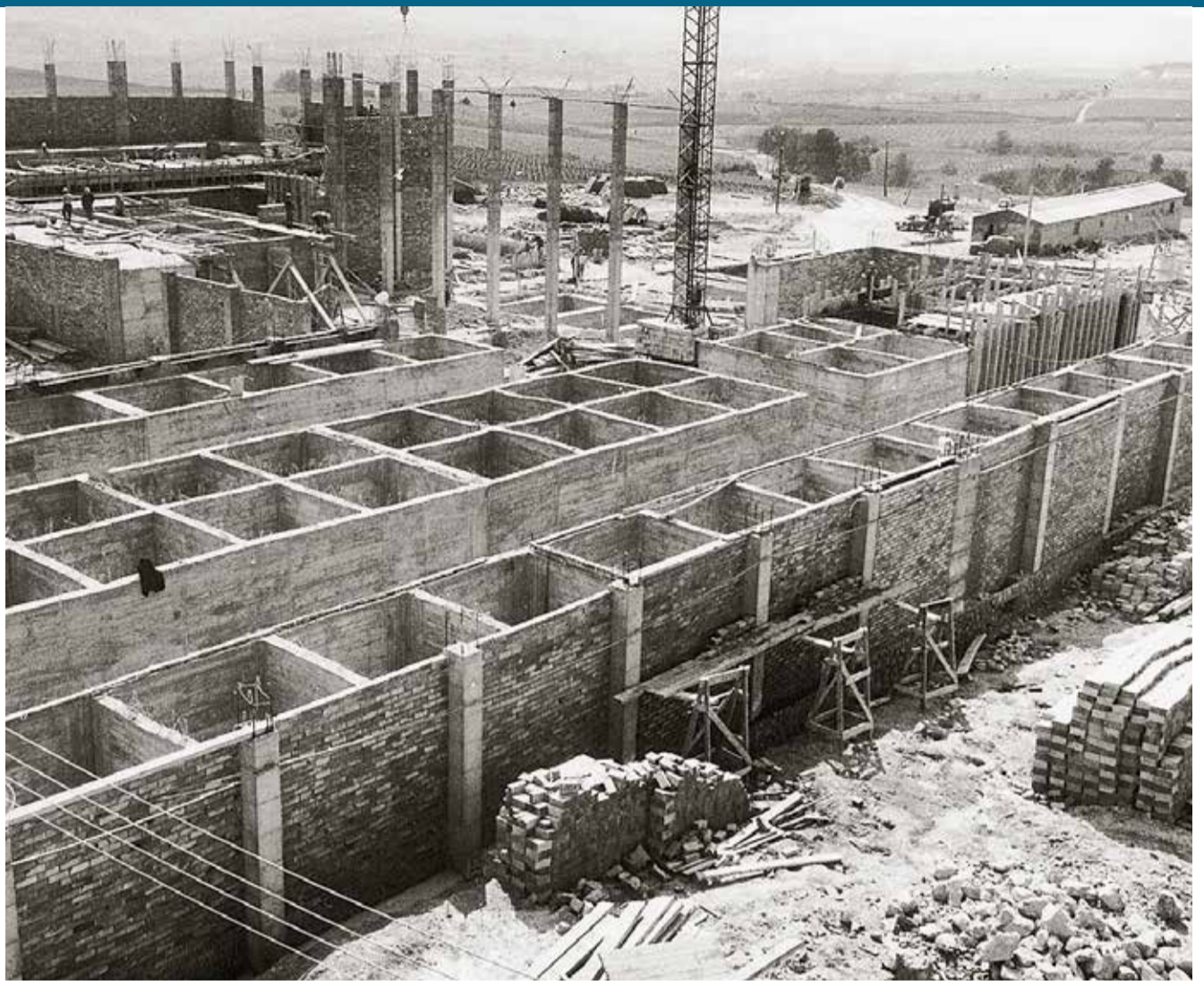
El celler Prunamala es va construir en una finca de 13 hectàrees de superfície adquirida l'abril de 1964. La foto de les obres es va fer el 25 de març de 1965. ✖ FOTO ESTUDIO PACO. ARXIU COVIDES
